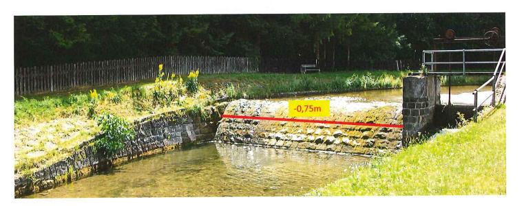
Als Kompensation für die Entfernung des Plattner Wehrs wurde der Werkskanal (328 lfm DN800) bis zum Weinzettel-Wehr errichtet. QA=0,75m³/s
